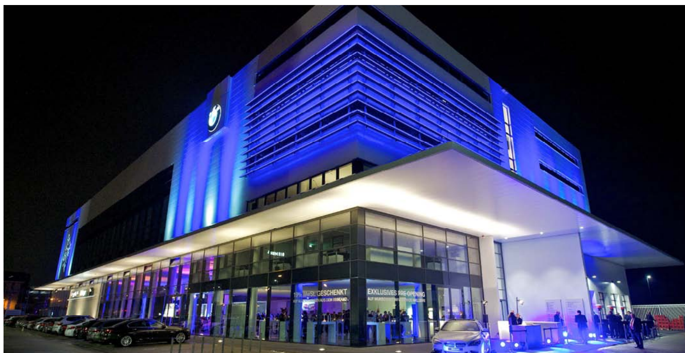
10. Oktober 2015: Die Eröffnung des Neubaus von BMW Nefzger an der Nonnendammallee.
